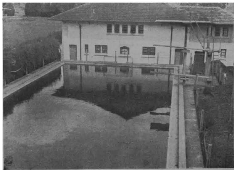
Aspéto da piscina, vendo-se ao lado os serviços para levantamento das arquibancadas
