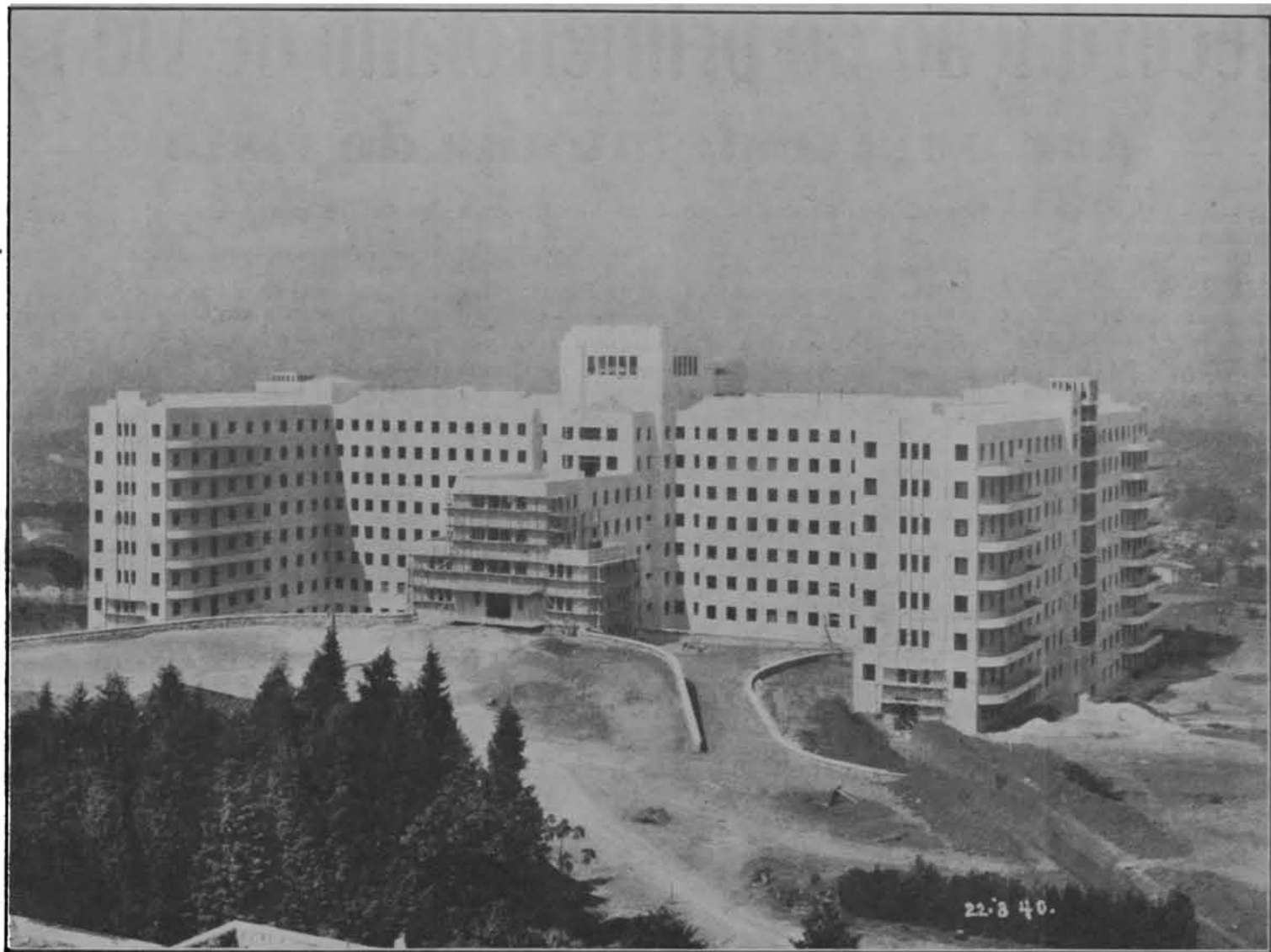
ASPÉCTO ATUAL DAS OBRAS — VISTA ANTERIOR
