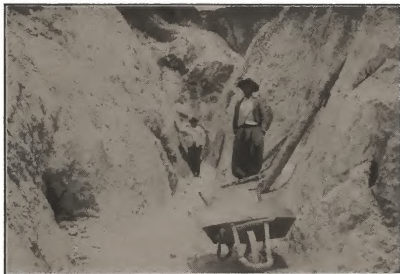
Fig. 2 - Mina Campinas, mun. de Encruzilhada. Trincheira aberta no granito alterado, rico de faixas greisenificadas e com disseminação de cassiterita.
