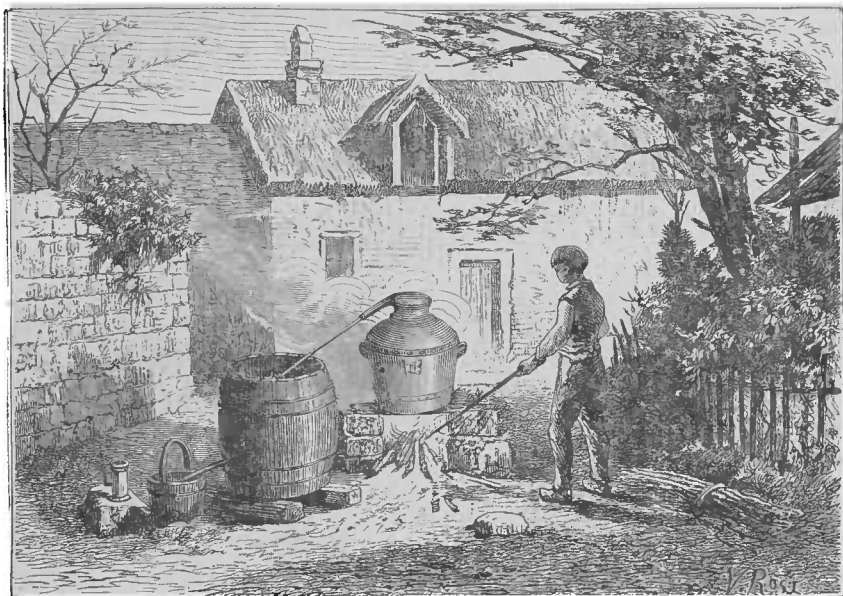
Fig. 157. — Alambic primitif pour la fabrication des eaux-de-vie.
